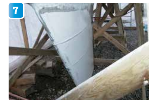
När spacket har härdat tas mallarna bort. Sedan fylls mellanrummen igen med NM Spackel 205 eller NM Spackel 206 Lätt. När spackelsträngarna har härdat slipas de jämna.
