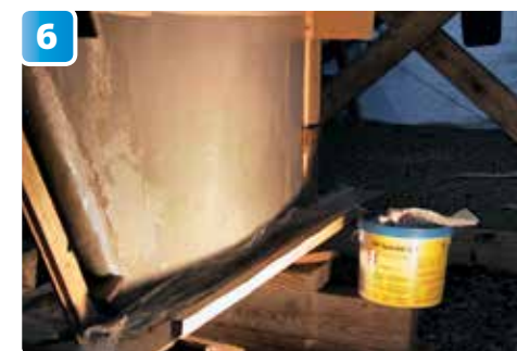
Nästa steg är att epoxispackla ytorna mellan mallarna. Epoxispacket som används är NM Spackel 206 Lätt. Mellan varje härdat spackellager slipas spacket med 40–80-kornspapper. Det går bra att handslipa eller använda oscillerande maskin.
