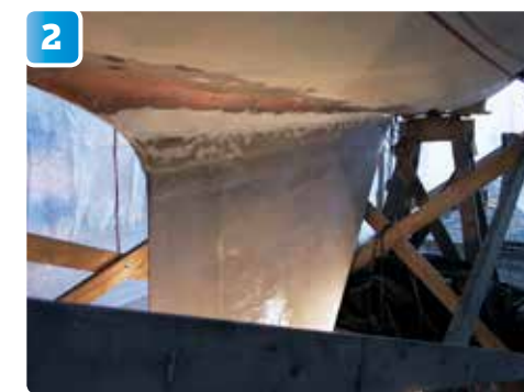
Expressbåten lyfts högt upp på bockar och stötor för att man ska komma åt kölens undersida. Kölen blåstras och ytbehandlas med två lager NM Stålsprimer 270. För att förstärka kölen används två lager 300 grams glasväv i NM Laminering 275.
