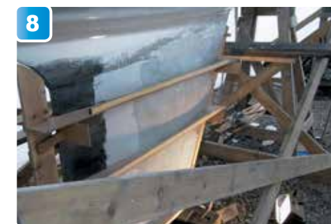
Kölprofilen kontrolleras ytterligare en gång med hjälp av mallarna. Efter härdning, finspackling och finslipning ytbehandlas kölen med två lager NM Laminering 275 innan allt bottenmålas.
